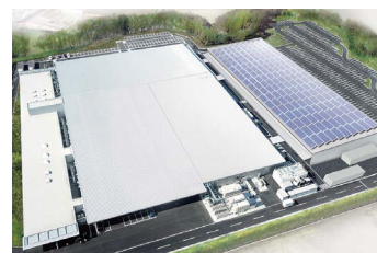
太陽光パネル
